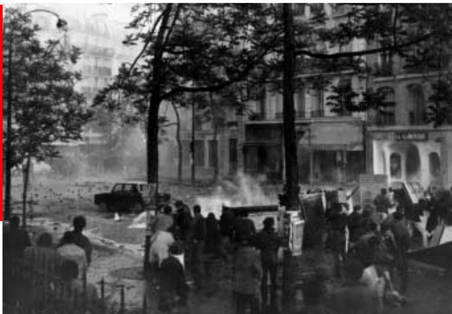
« J'ai pris cette photo du square de l'église Saint-Germain. Nous sommes au carrefour de la rue de Rennes et du Boulevard Saint-Germain. Les affrontements étaient très violents. Par sécurité, les photographes se déplaçaient par petits groupes de 5 ou 6. » G. A.
